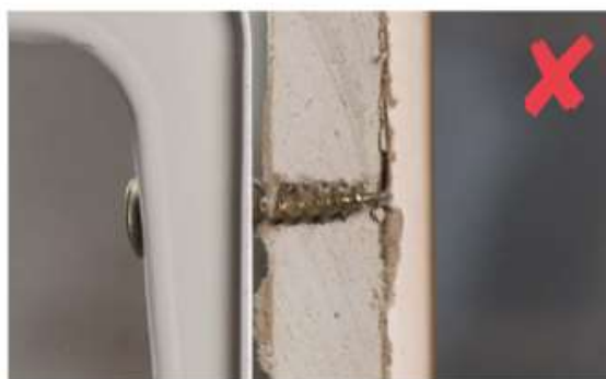
Netinkamas tvirtinimas per plokštę
